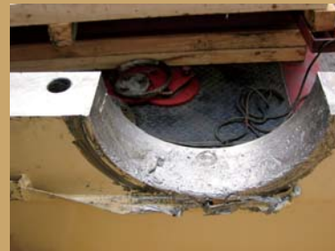
受損之軸承承托面後經噴焊修復
